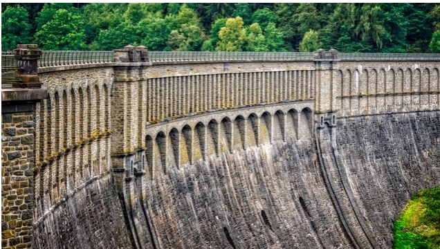
staumauer, mauer, talsperre
