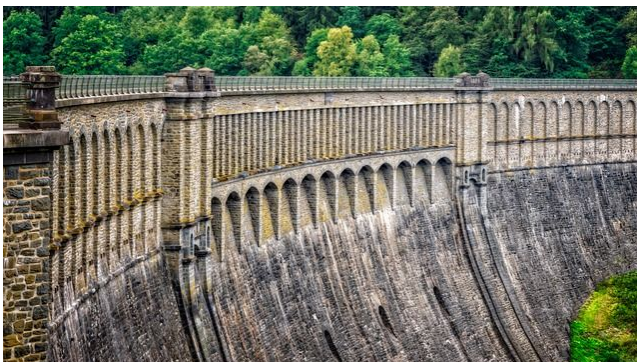
staumauer, mauer, talsperre
