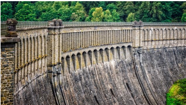
staumauer, mauer, talsperre
