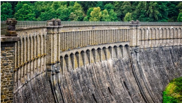
staumauer, mauer, talsperre
