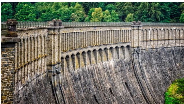
staumauer, mauer, talsperre
